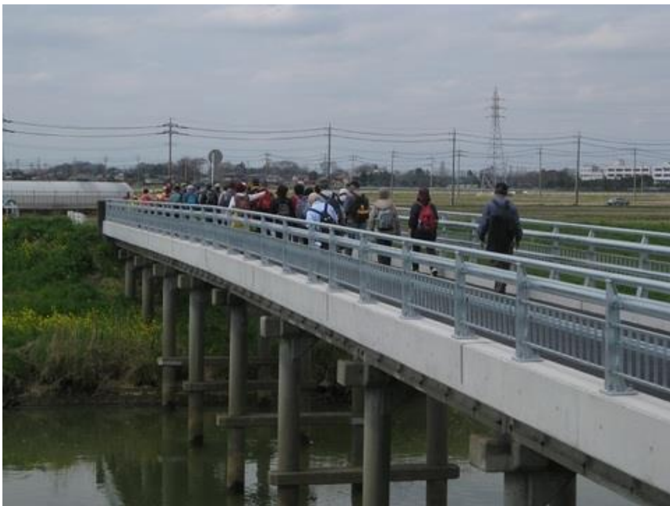
中川に架かる「赤岩橋」は風情ある木の橋からコンクリート橋に改築され、4日前に開通したとの事でした。
