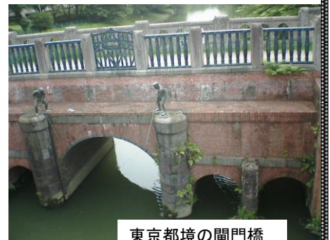
東京都境の閘門橋
