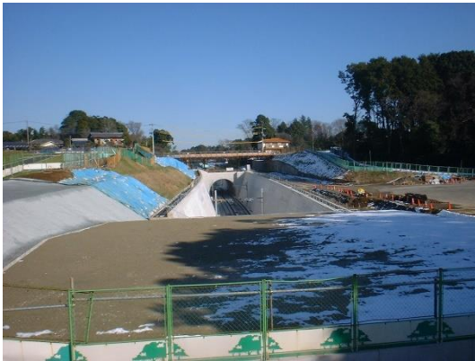
南流山地下トンネルの筑波側出口
